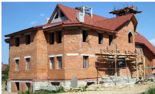
Budowa, czerwiec 2008 r., kościół przykryty dachem, widok od strony zaplecza duszpastersko-katechetycznego.
