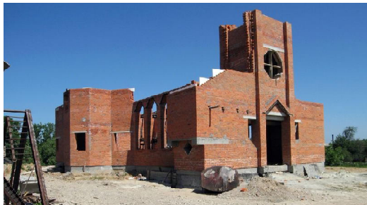
Budowa, czerwiec 2007 r., coraz bardziej widoczny kościół.
