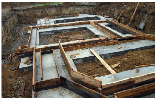
Budowa kościoła, fundamenty zaplecza duszpastersko-katechetycznego, październik 2006 r.
